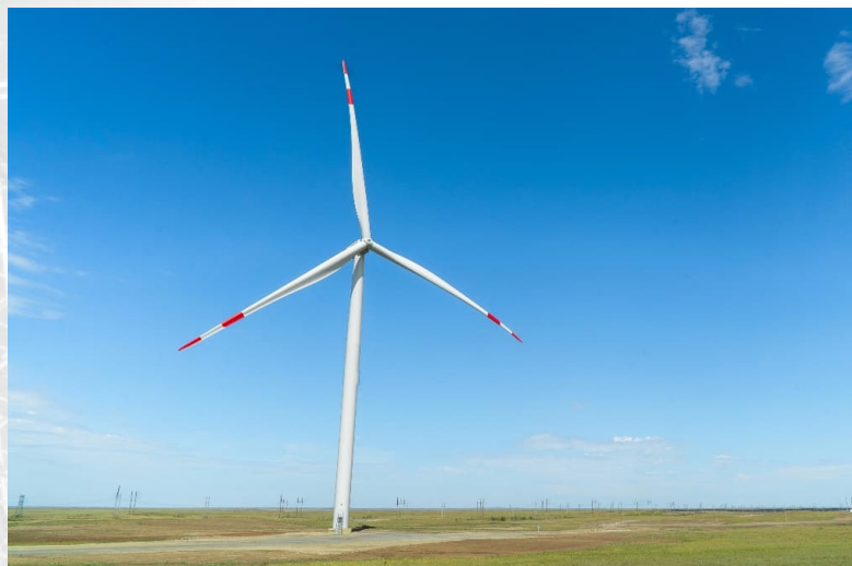
ВЭС Бадамша-1 мощностью 48 МВт
