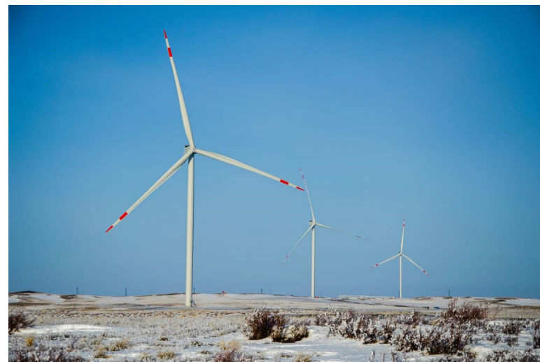
ВЭС Бадамша-2 мощностью 48 МВт
